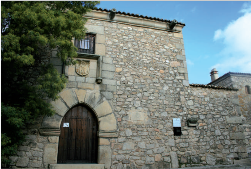
Estado actual de la rehabilitada casa de la familia Pizarro en Trujillo (Fotografía: José M a González Ochoa)
