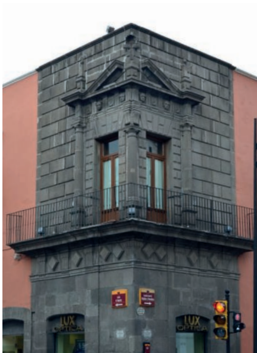
Figura 7. Balcón situado entre las calles 4 sur y 3 oriente, Puebla (México)
